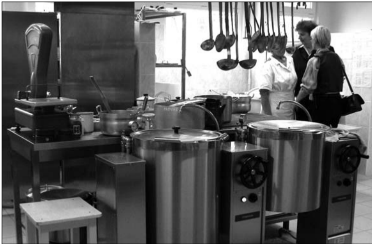
Jaunas tehnoloģiskās iekārtas rekonstruētajā ēdināšanas blokā "Ābelītē".
