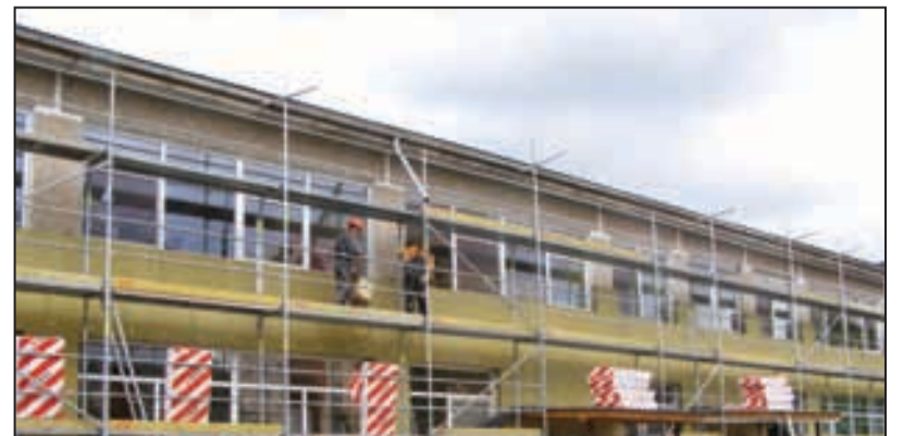
PII "Dzērvenīte" ārējās fasādes siltināšana
