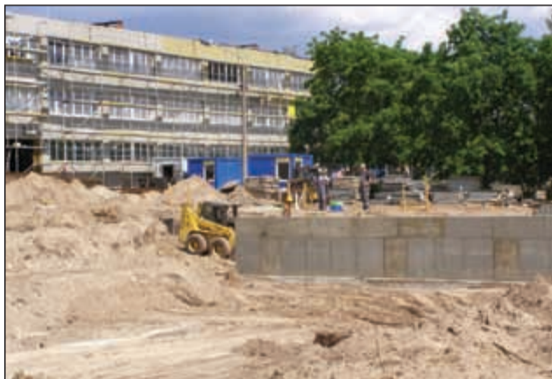
Peldbaseina pamatu betonēšana
