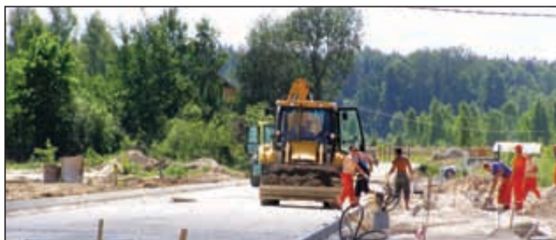
Būvē Stacijas ielas turpinājumu
