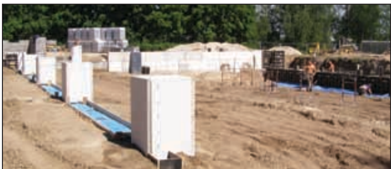
Olaines peldbaseina pamatu betonēšana
