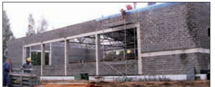
Продолжается строительство городского бассейна
