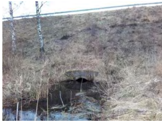
Attēls 47, Attēls 48 Uz neatbilstošām teknes augstuma atzīmēm izbūvēta caurteka / tilts uz koplietošanas novadgrāvja 384245:01 šķērsojuma vietā ar dzelzceļu un 80m zemāk lejtecē esoša caurteka nobrauktuves/uzbrauktuves, kas savieno autoceļus A5 un A8
