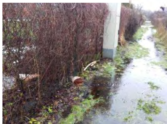
Attēls 65, Attēls 66 N-3 lejpus dīķa pie „Cērpām” izplūst pa zemes virsu
