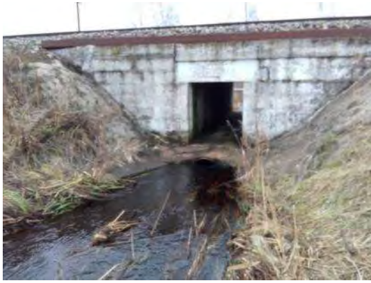
Attēls 47, Attēls 48 Uz neatbilstošām teknes augstuma atzīmēm izbūvēta caurteka / tilts uz koplietošanas novadgrāvja 384245:01 šķērsojuma vietā ar dzelzceļu un 80m zemāk lejtecē esoša caurteka nobrauktuves/uzbrauktuves, kas savieno autoceļus A5 un A8
