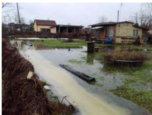
Attēls 55, Attēls 56 Paraleli N-1 un S-1 esoši grāvji bez noteces
