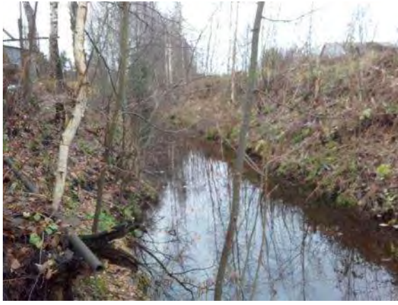
Attēls 78, Attēls 79 N-5 lejtece un vietējas nozīmes grāvis, kurš ietek N-5 un neatbilstošas konstrukcijas un diametra caurteka uz tā
