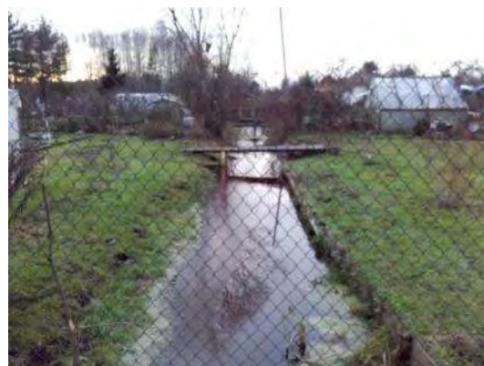
Attēls 55, Attēls 56 Paraleli N-1 un S-1 esoši grāvji bez noteces
