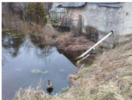
Attēls 146, Attēls 147 Galvenajos novadgrāvjos uz sūkņu stacijām paaugstināts ūdens līmenis
