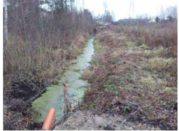
Attēls 78, Attēls 79 N-5 lejtece un vietējas nozīmes grāvis, kurš ietek N-5 un neatbilstošas konstrukcijas un diametra caurteka uz tā
