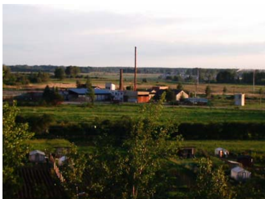
9.1.1.attēls Katlu māja Jaunolainē
