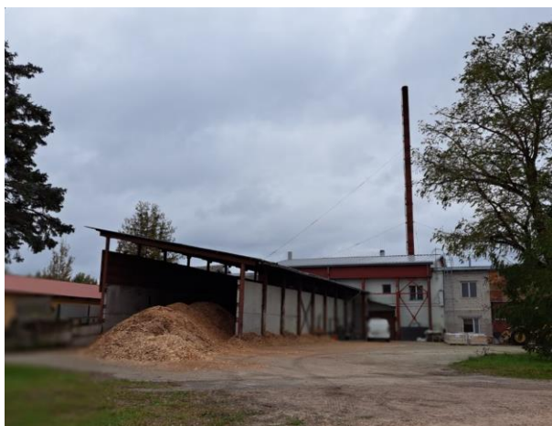
16. attēls. Esošās katlu mājas būves autoceļa A8 pretējā pusē
