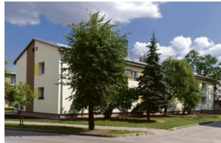
Renovēta māja Zemgales ielā 13
