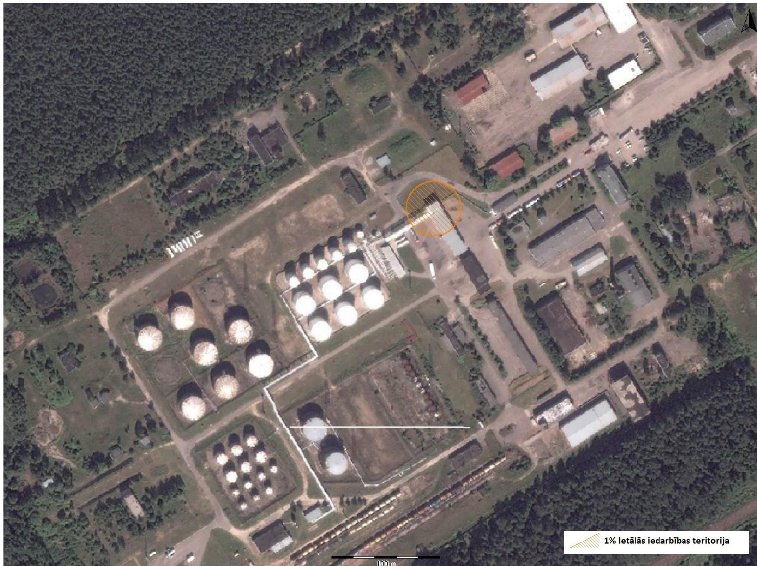
2.21.attēls. Maksimālās 1% letālās iedarbības zona benzīna peļķes ugunsgrēka gadījumā autocisternu uzpildes, noliešanas stacijā (piemērs, benzīna uzpilde)
